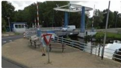
De beweegbare brug bij Deverbrug (archief foto)
